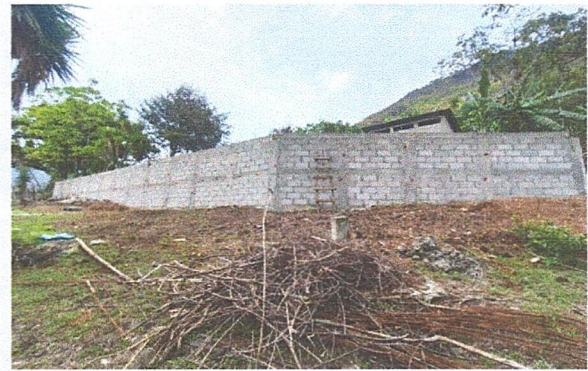
Foto 4: Remozamiento de muro de contención finalizado
