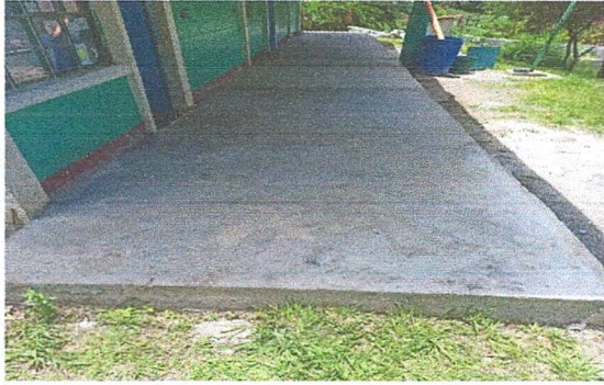
Foto 1: Remozamiento de piso finalizado
