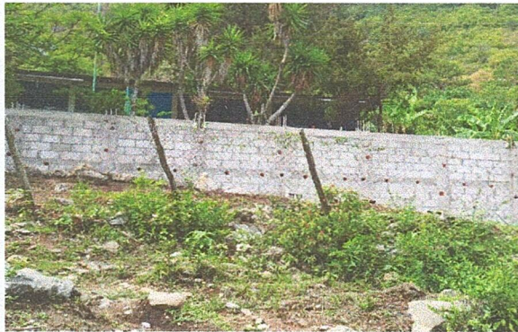
Foto 3: Remozamiento de muro de contención finalizado
